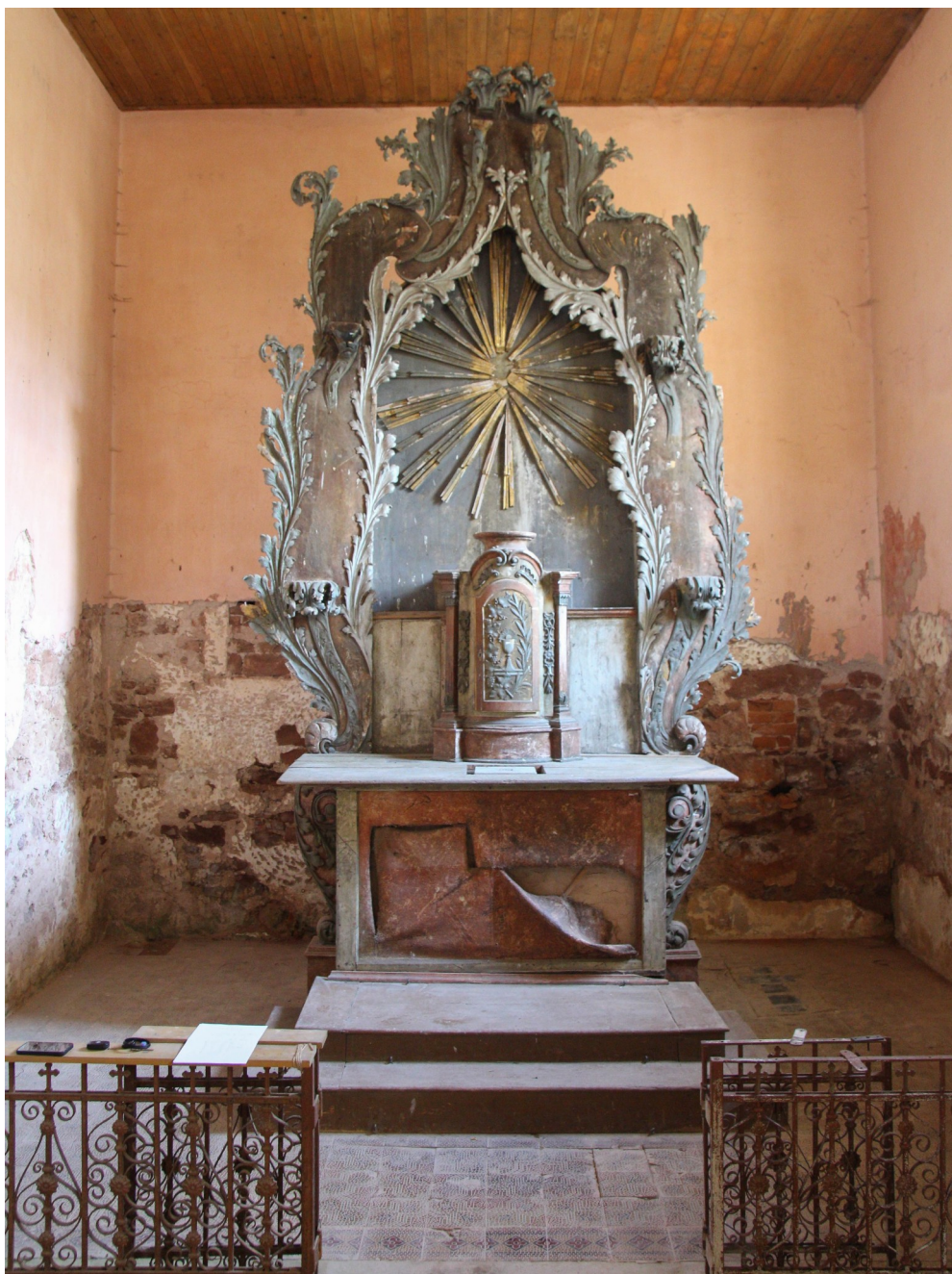
Současný havarijný stav hlavného oltára.
